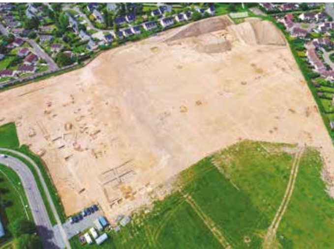
Vue aérienne du chantier
