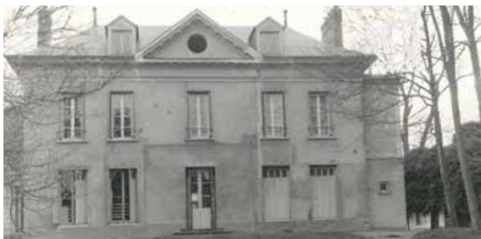
Château du Cèdre avant sa démolition
